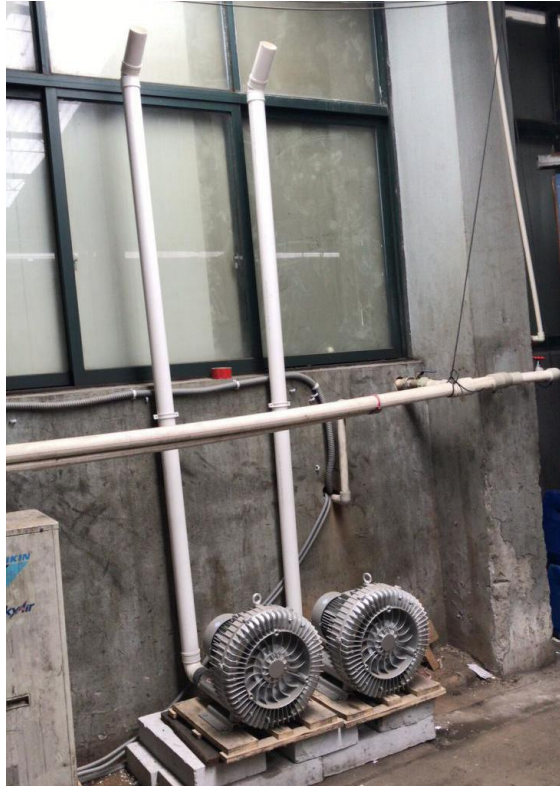
图4-1 车间机械通排风设备
