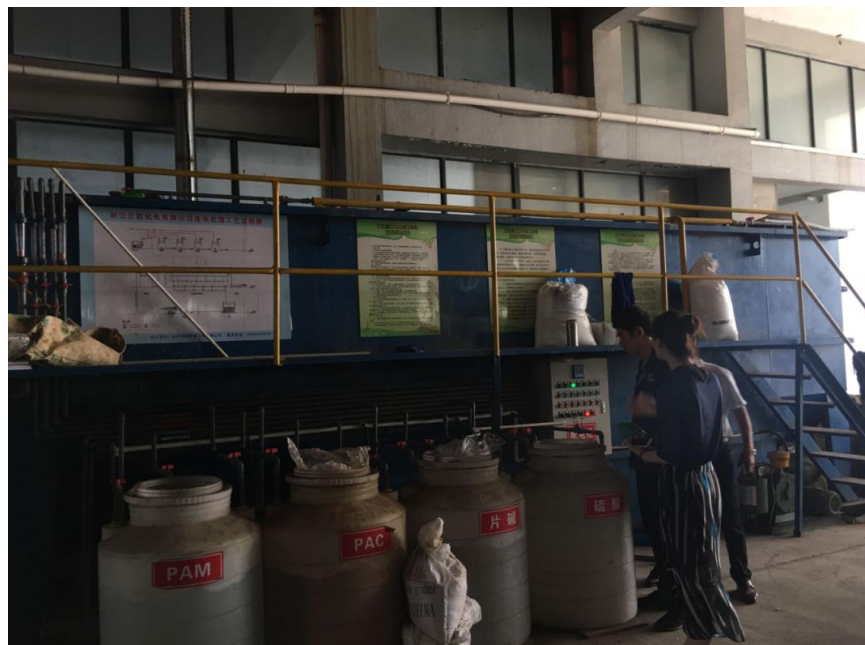
图4-6 清洗废水处理设施
