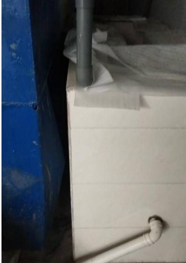
图4-7 清洗废水处理后排出口
